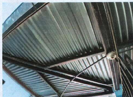
Foto 4: Mantenimiento a estructura metálica en el área de las aulas (lijado y pintura).
