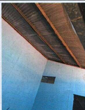
Foto 3: ESTRUCTURA DE TECHO Sustrucción de estructura de techo en áreas de los baños, área de pila y comedor.
