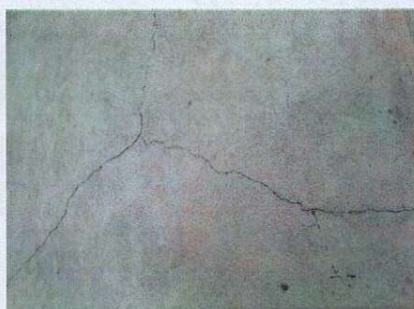
Foto 5: LOSA DE PATIO Reparación a losa de concreto en mal estado en patio, de un espesor de 8.00 cm.
